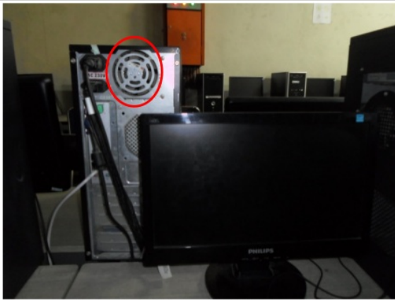
Foto 21. Peletakan CPU tidak safety
